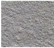
CSP 5 (medium shotblast)
