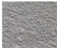
CSP 5 (medium shotblast)
